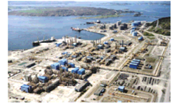
STATOIL REFINERY, KÅRSTØ - NOR
